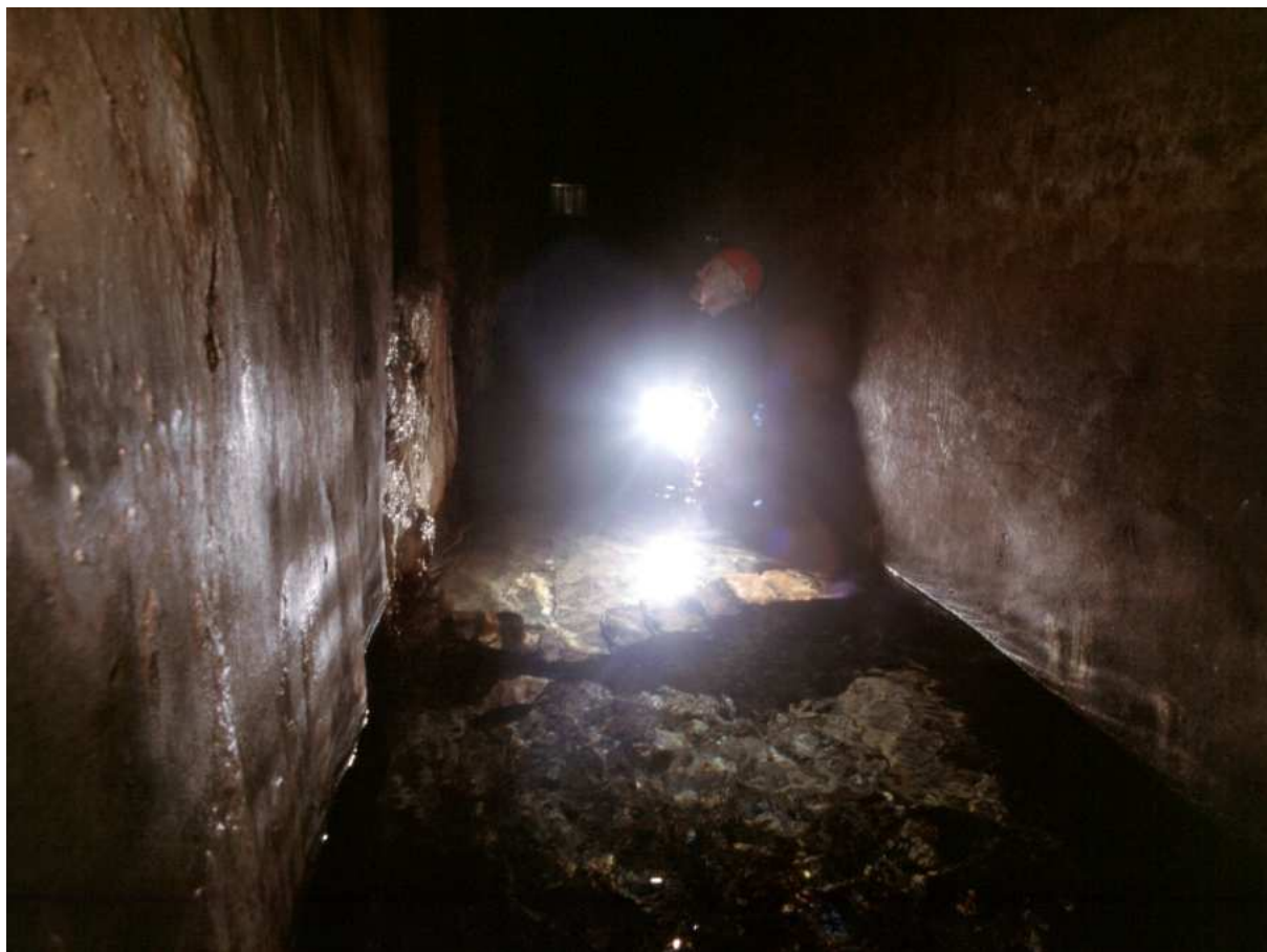
Figura 16. Il canale del Vergine in corrispondenza della Chiocciola. Sotto il pelo dell'acqua è visibile una traccia di muratura, identificabile come residuo di traversa idraulica (foto C. Germani).
