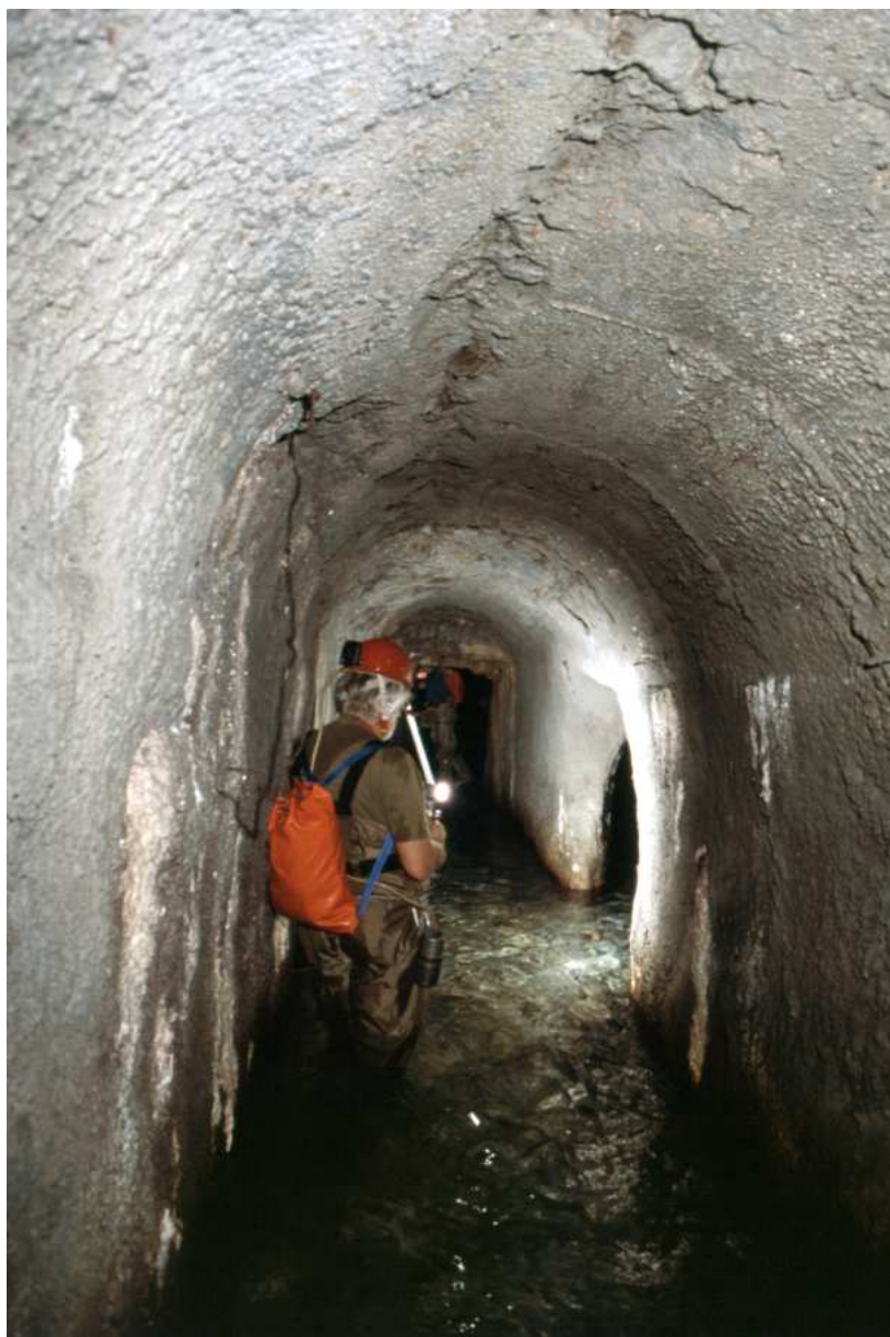
Figura 9: il canale del Vergine in corrispondenza dell'uscita del bypass (foto C. Germani). Figure 9: the Virgin channel at the bypass exit (photo C. Germani).
