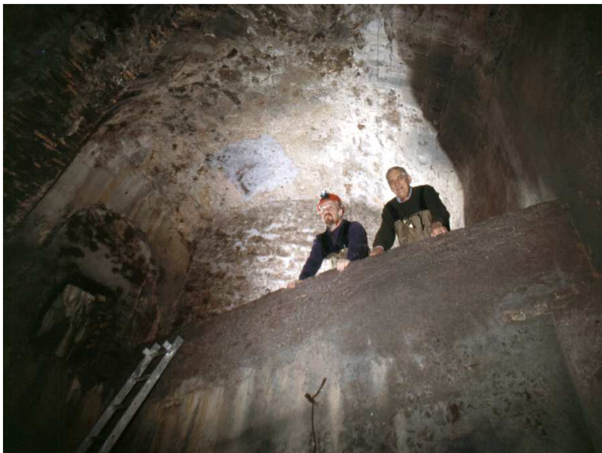
Figura 10: il terrazzino alla base della scala di 118 gradini (foto C. Germani). Figure 10: the small balcony at the base of the 118 step staircase (photo C. Germani).
