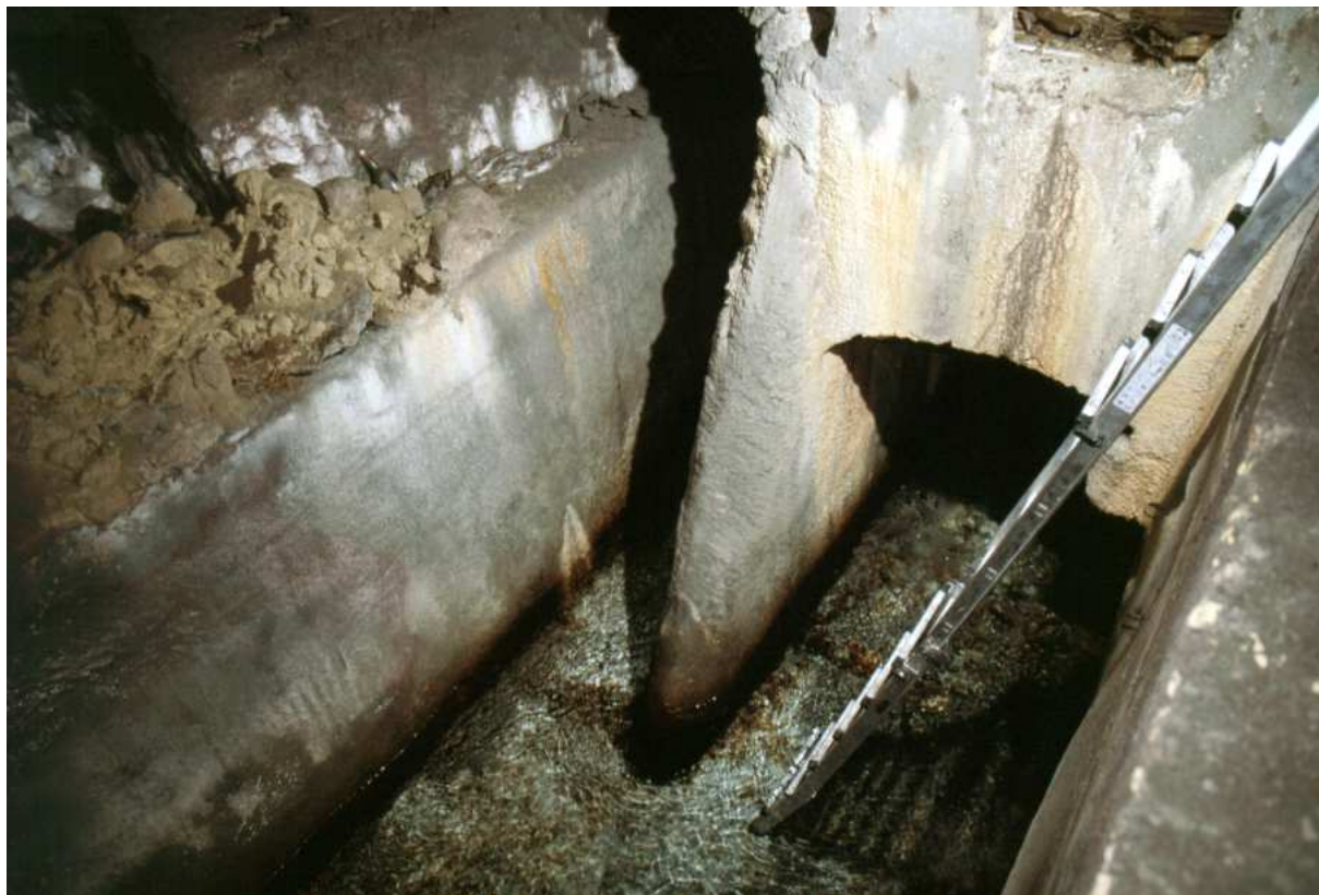
Figura 8: il canale del Vergine oggi, in corrispondenza della prima macchina realizzata da Agrippa. Della struttura resta solo il canale di bypass e gli ambienti ove alloggiava la grande ruota idraulica. A destra la base e la camera di manovra relativa al prelievo ottocentesco dell'Accademia di Francia (foto C. Germani).
